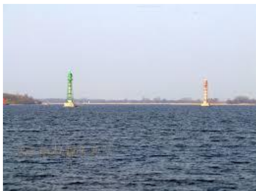
Rysunek 2. Zdjęcie Bramy Torowej (BT). Na Zalewie Szczecińskim, wzdłuż toru wodnego rozmieszczone są cztery Bramy Torowe.
